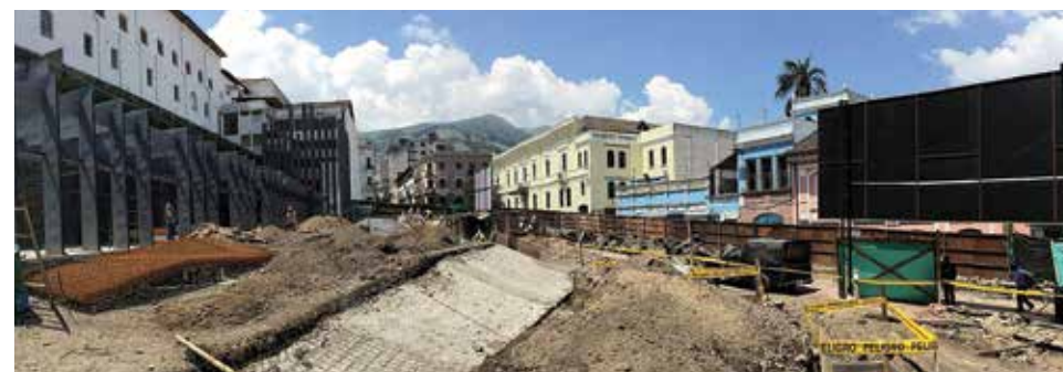
Proceso de construcción
